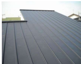
屋根: ガルバリウム鋼板
