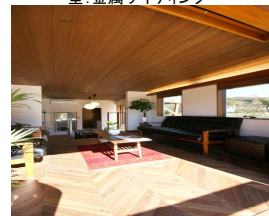
床:無垢材 ヘリンボーン張り
