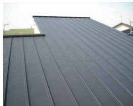
屋根:ガルバリウム鋼板
