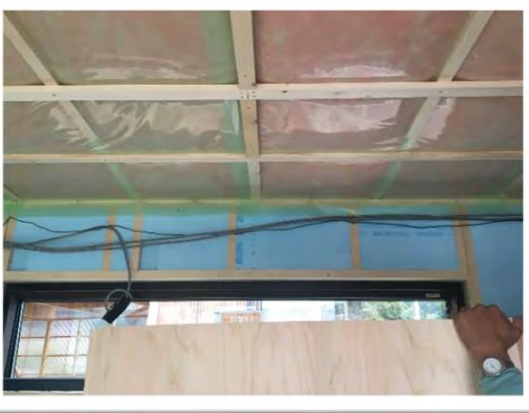
天井:太陽SUN 高性能グラスウール断熱材 105mm
