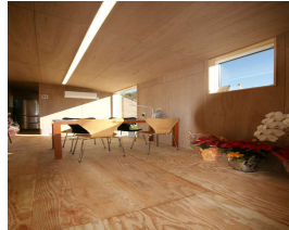
床: ベニヤ張り
